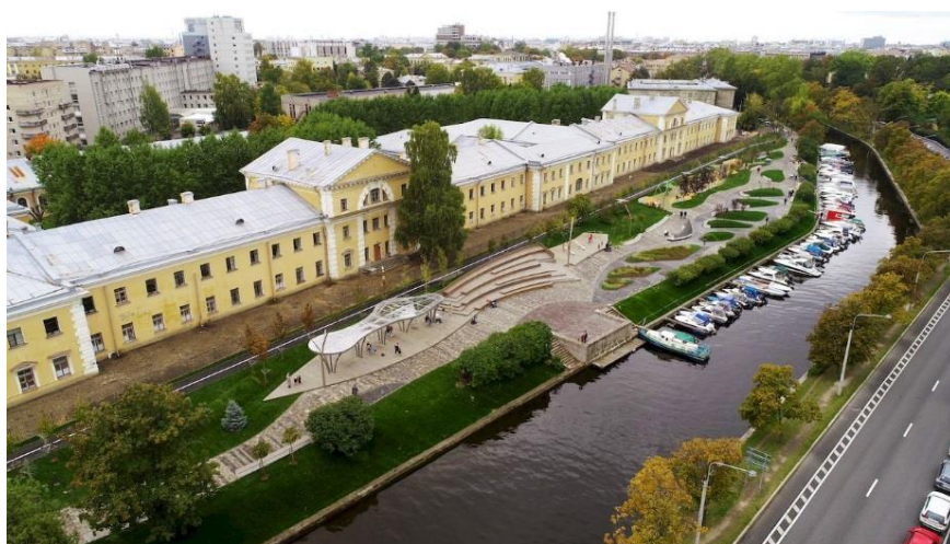
Рис. 2. Набережная реки Карповка, Санкт Петербург
