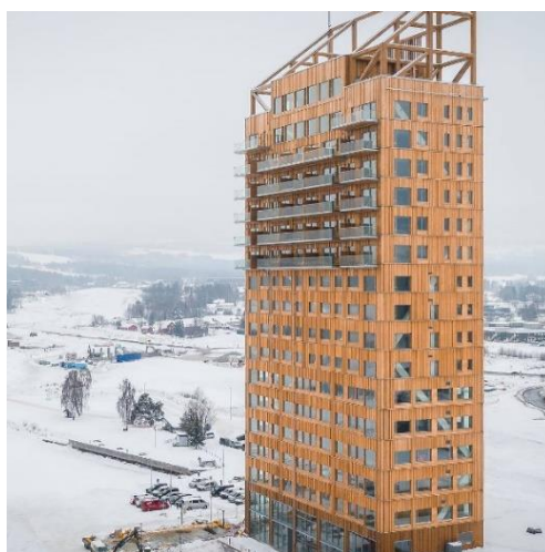
Рис. 1. Mjøstårnet Tower, Брюмундал, 2019 г.
