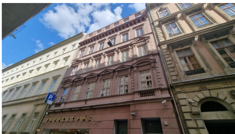
Рис. 2. Парковка в историческом здании после реконструкции, паркинг Franklin Parkolohaz
