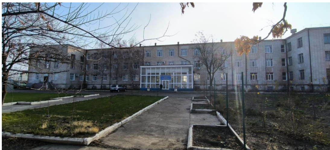
Рис. Общий вид административного здания
