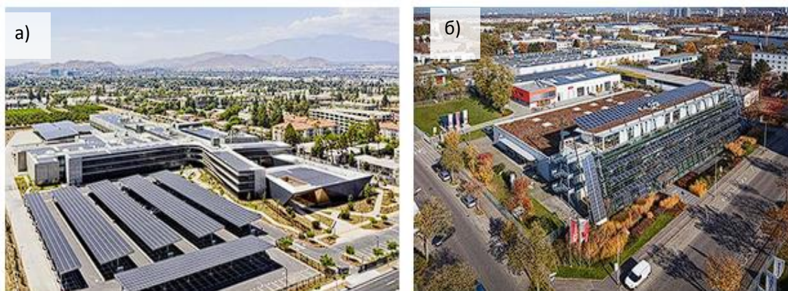
Рис. 2. Степень выраженности фотоэлектрической системы: а) скрытая система (испытательный центр CARB); б) видимая система (корпус Solar Campus)
